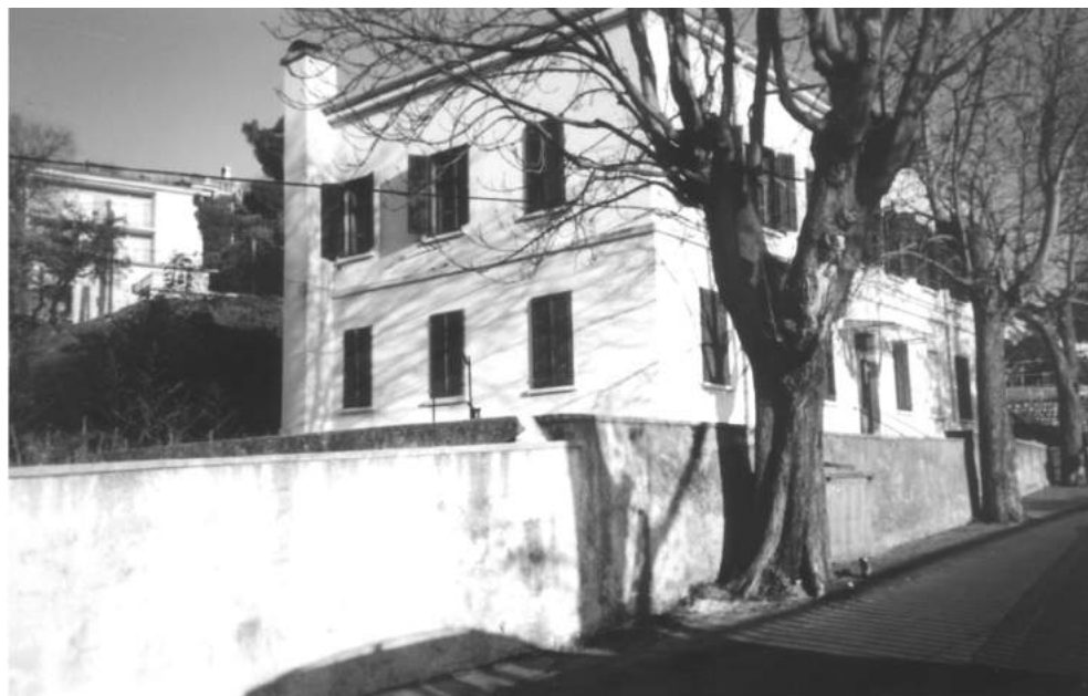
Foto 2. La scuola di Santa Lucia (Sv. Lucija) di Kostrena come è attualmente. Lo scantinato è ampio quanto l'intero perimetro dell'edificio e vi si accede da una scala esterna.
