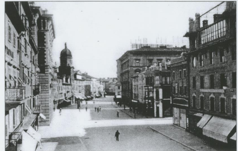
FIUME - Corso Re Vittorio Emanuele III
