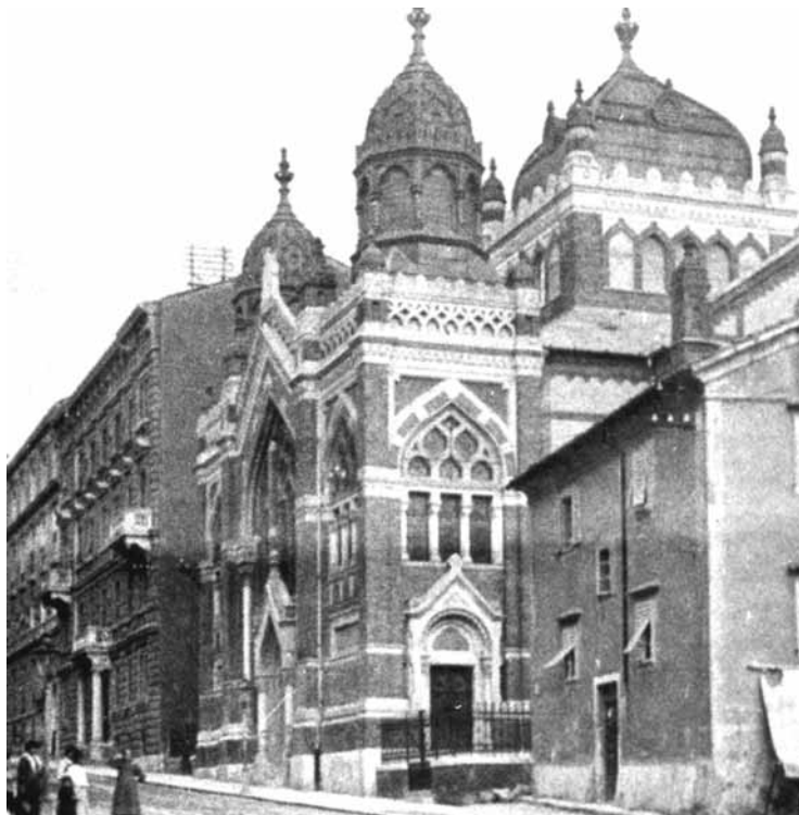
La Sinagoga di Fiume incendiata dai tedeschi il 30 gennaio 1944
