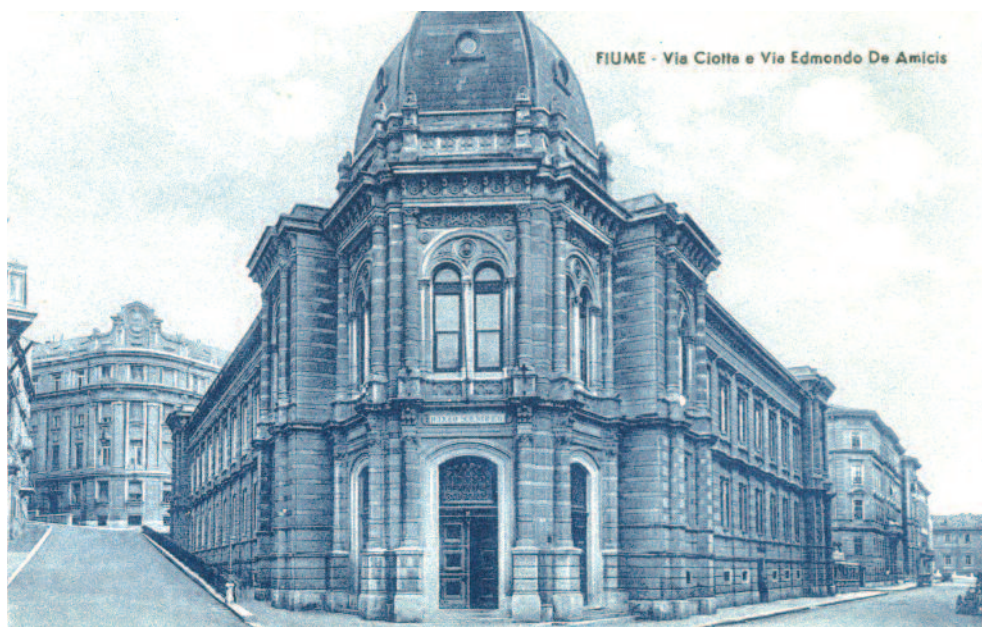
Sede del Liceo italiano di Fiume dove fu costituita nel 1923 la Società di Studi Fiumani
